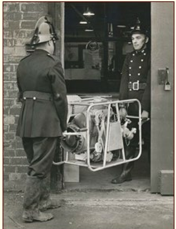
Een Rover gasturbine in gebruik door de brandweer als waterpomp.
