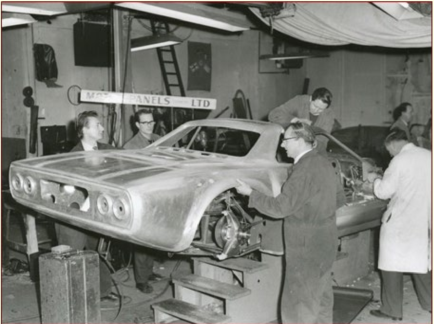
De gasturbine Rover-BRM in opbouw voor de 24 uur van Le Mans.
